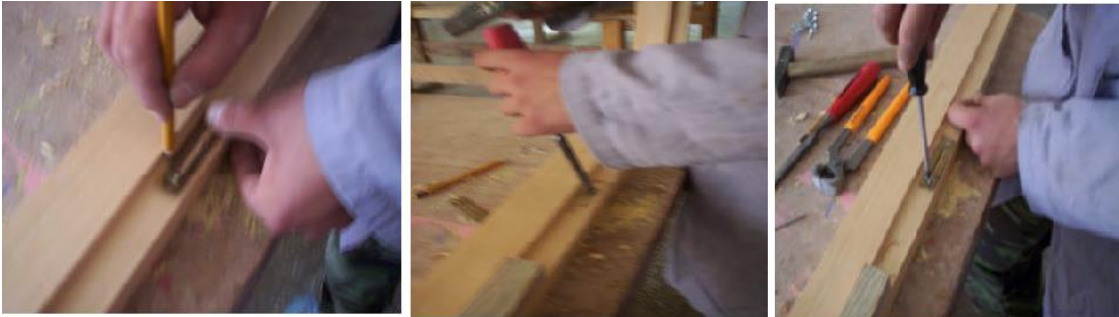
Şəkil 3.39. Pəncərə çərçivəsində kilidin dilçə yuvasının yeri nişanlanır, yuva açılır və dilçə yuvasının metal üstlüyü bərkidilir
