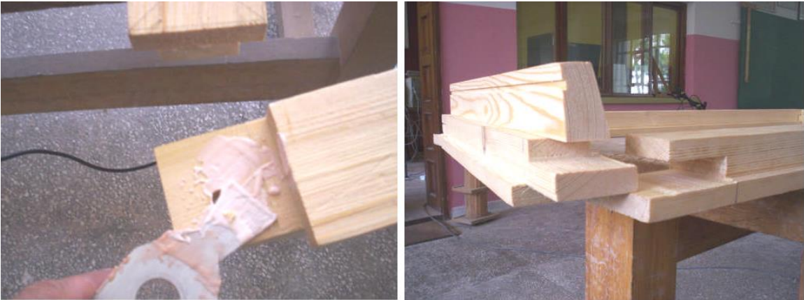
Şəkil 2.44. Dilçələrə yapışqan çəkiliş və birləşmə yerinə yetirilir.
