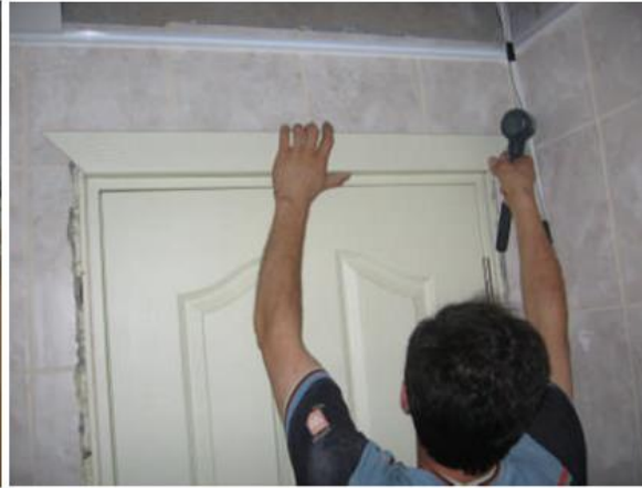
Şəkil 1.88. Hazır blokun tam bərkidilməsi
