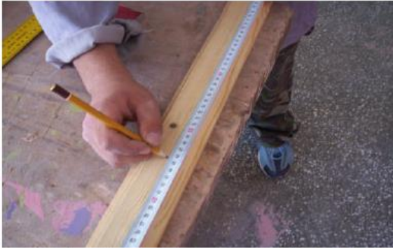
Şəkil 3.35. Pəncərə layının ortası tapılır və kilidin yeri nişanlanır.
