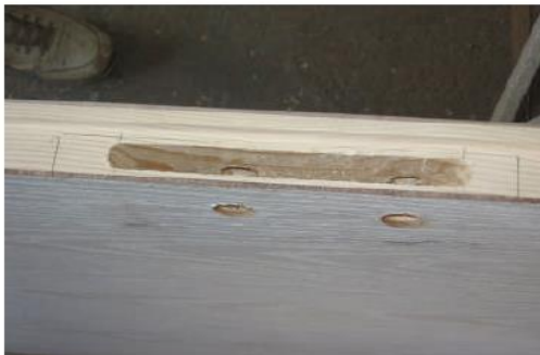
Şəkil 3.22. Kilid yuvasının iskənə ilə işlənilib tam hazır vəziyyətə gətirilməsi
