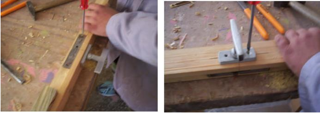
Şəkil 3.38. Kilid yuvasına salınır və dəstək bərkidilir
