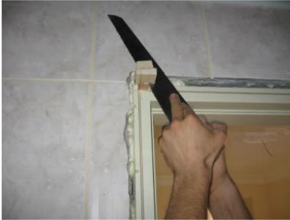
Şəkil 1.88. Hazır blokun tam bərkidilməsi
