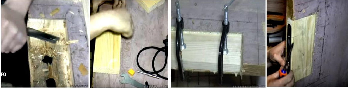
Şəkil 3.40. Kilid yerlərinin təmiri
