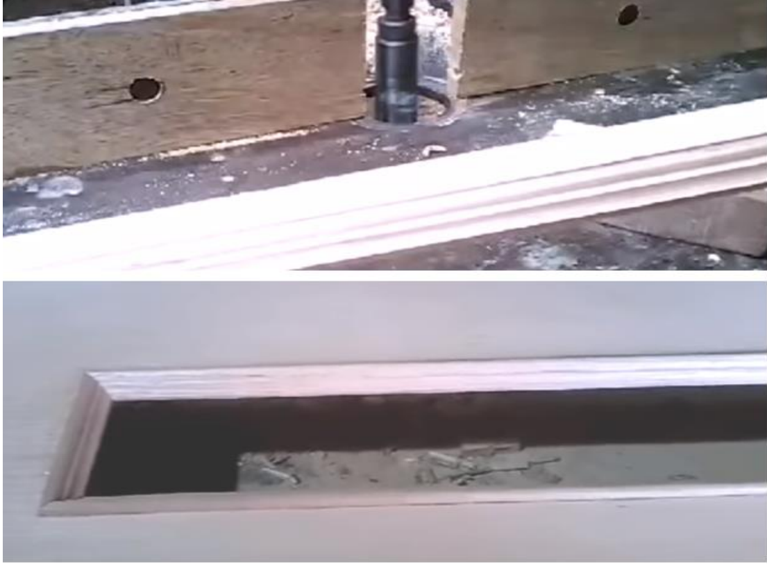
Şəkil 1.82. Qurşaqların şüşə boşluğuna salınması
