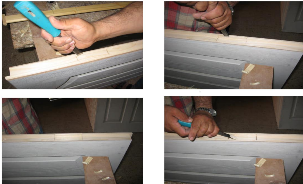
Şəkil 3.17. Həcnamaların yerləri hazırlanır
