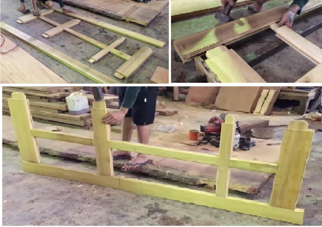
Şəkil 1.69. Brusların müvəqqəti yığılması
