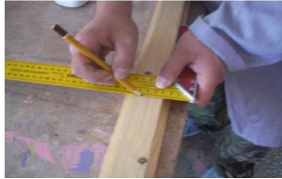
Şəkil 3.35. Pəncərə layının ortası tapılır və kilidin yeri nişanlanır.
