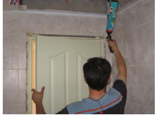
Şəkil 1.87. Boşluqların doldurulması
