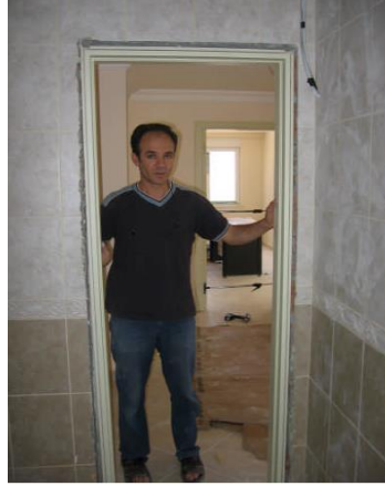
Şəkil 1.85. Çərçivənin qoyulması
