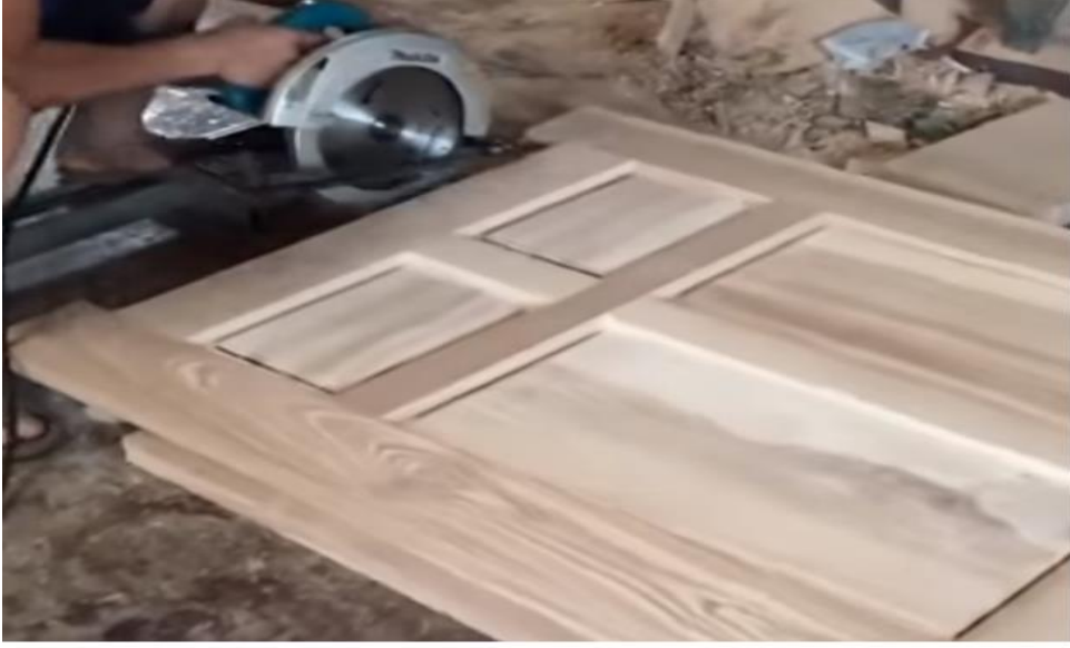
Şəkil 1.80. Artıq hissələrin kəsilməsi
