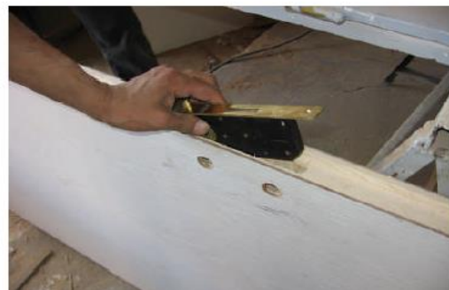
Şəkil 3.22. Kilid yuvasının iskənə ilə işlənilib tam hazır vəziyyətə gətirilməsi
