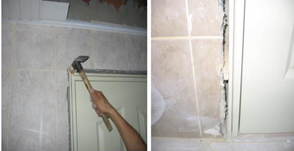
Şəkil 1.86. Çərçivənin bərkidilməsi
