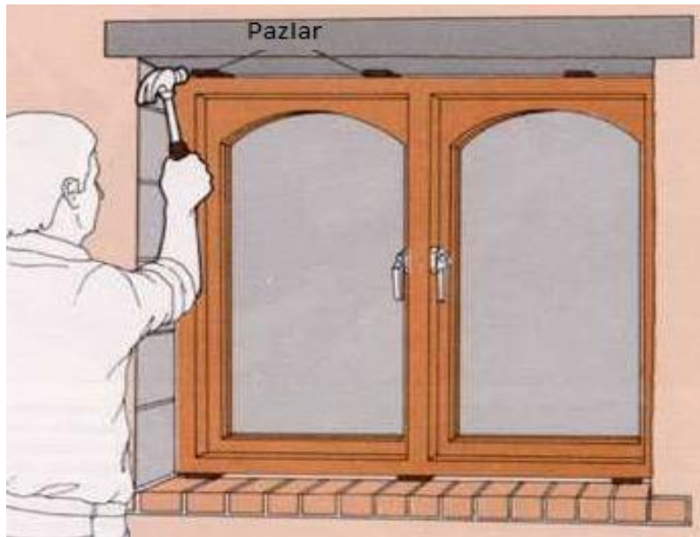
Şəkil 2.53. Pəncərə blokunun divar boşluğuna qoyulması
