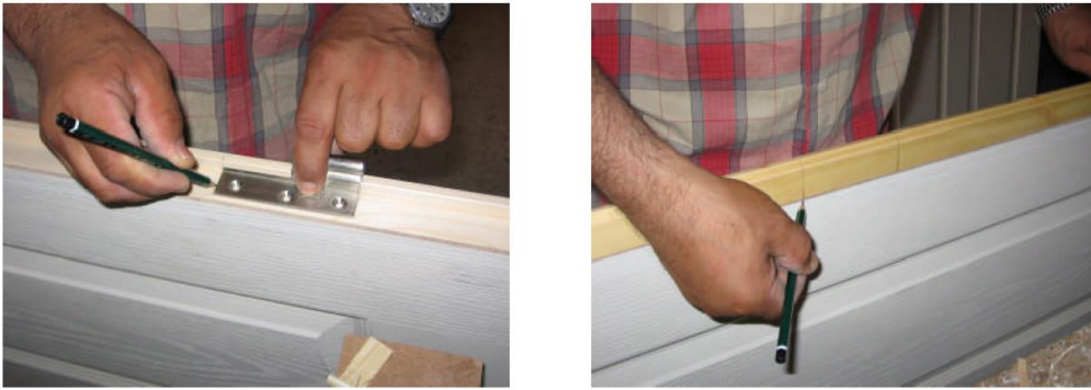
Şəkil 3.16. Həcnamaların yerləri nişanlanır
