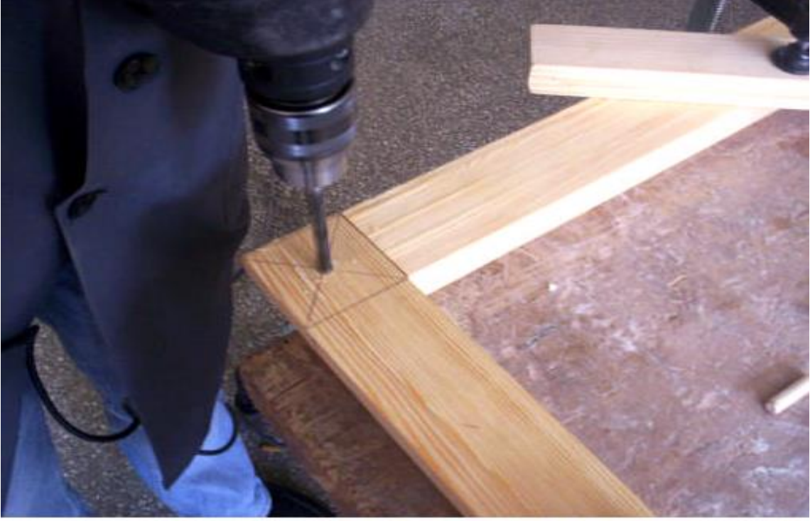
Şəkil 2.43. Nagelin diametrinə görə brusda deşik açılır.
