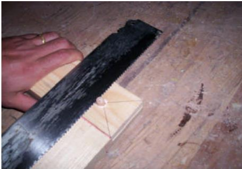
Şəkil 2.46. Nagellərin artıq hissəsi narın dişli əl mişarı ilə kəsilir
