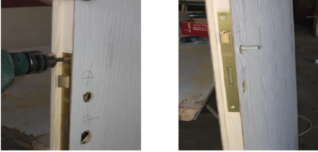
Şəkil 3.23. Qapı kilidinin yuvaya daxil edilməsi
