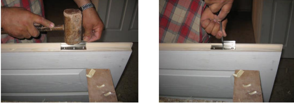
Şəkil 3.18. Həncamalar yuvaya bərkidilir.
