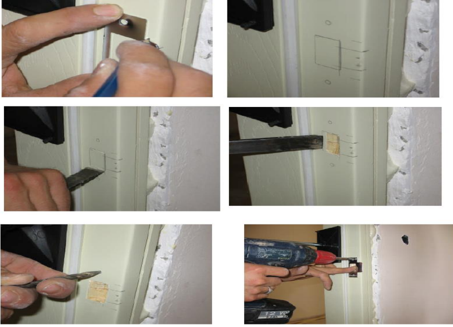
Şəkil 3.28. Qapı çərçivəsində dilçə yerinin açılması
