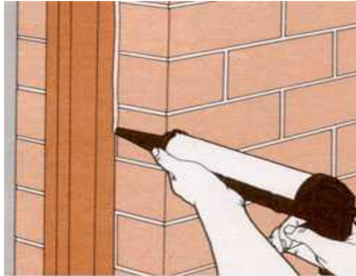
Şəkil 2.55. Ara boşluqların doldurulması
