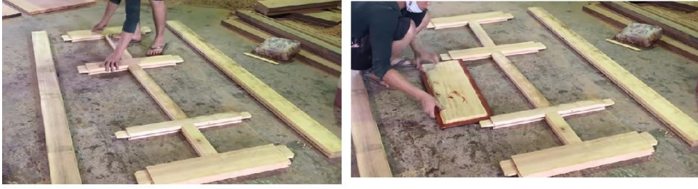
Şəkil 1.76. Xonçaların novlara qoyulması
