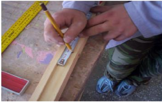
Şəkil 3.36. Kilid mərkəzi tapılır və kilid yuvası nişanlanır
