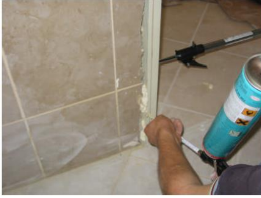
Şəkil 1.87. Boşluqların doldurulması
