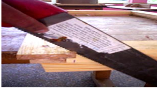
Şəkil 2.47. Layların qıraq bruslarındakı artıq hissələr narın dişli əl mişarı ilə kəsilir
