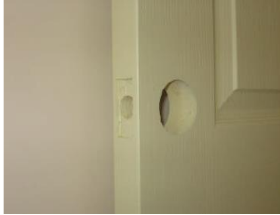
Şəkil 3.25. Qapı tayında kilid yuvası açılır
